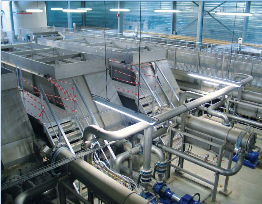
■ Рис. 2. Три флотационные установки МСН 40 после монтажа на станции водоподготовки в г. Леон (Франция)
